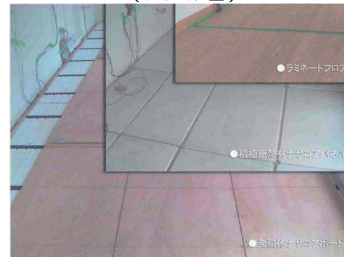
実測現場床施工写真（ひばりが丘団地 205号室）
